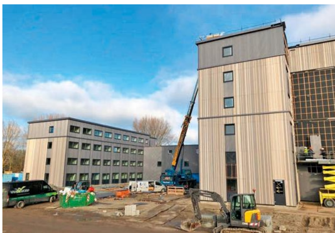
Met de op maat gemaakte geveldelen konden de gevels van de zes woonblokken in korte tijd bekleed worden.
